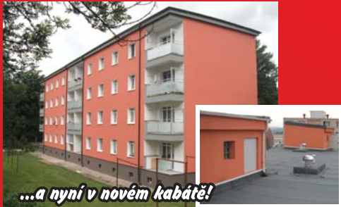
Původní stav před rekonstrukcí
